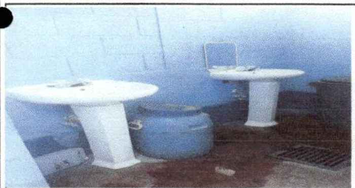
Foto 5: lavamanos nuevos en baño de mujeres.
